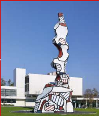
1996 Chaufferie avec cheminée Vitry-sur-Seine, France
